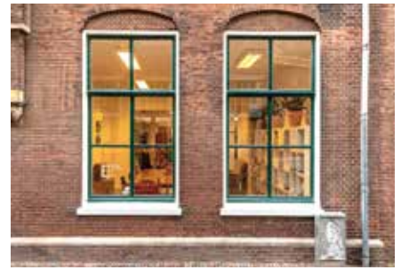
Moderne Vakuum-Isoliergläser sind so schlank wie ein Zweifach-Isolierglas, dämmen aber mehr als doppelt so viel Wärme und schützen gleichzeitig effektiv vor dem Straßenlärm.
